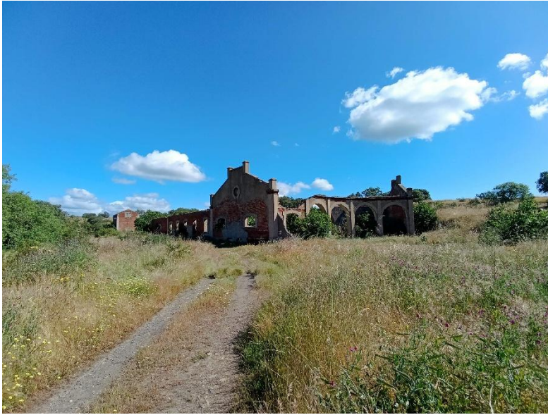
Estación ferroviaria minera Minas del Castillo
